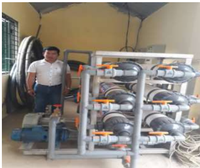
Hình 3.5: Mô hình công nghệ màng lọc kết hợp với vật liệu ODM-2F
