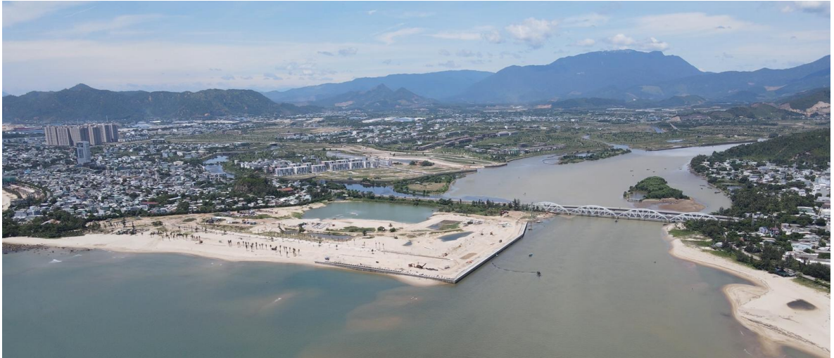
Hình 2.8. Lấn biển xây dựng khu đô thị - du lịch Nam Ô tại khu vực cửa sông Cu Đê (ảnh chụp từ UAV - Giang Tuấn Linh, 6/2023)
