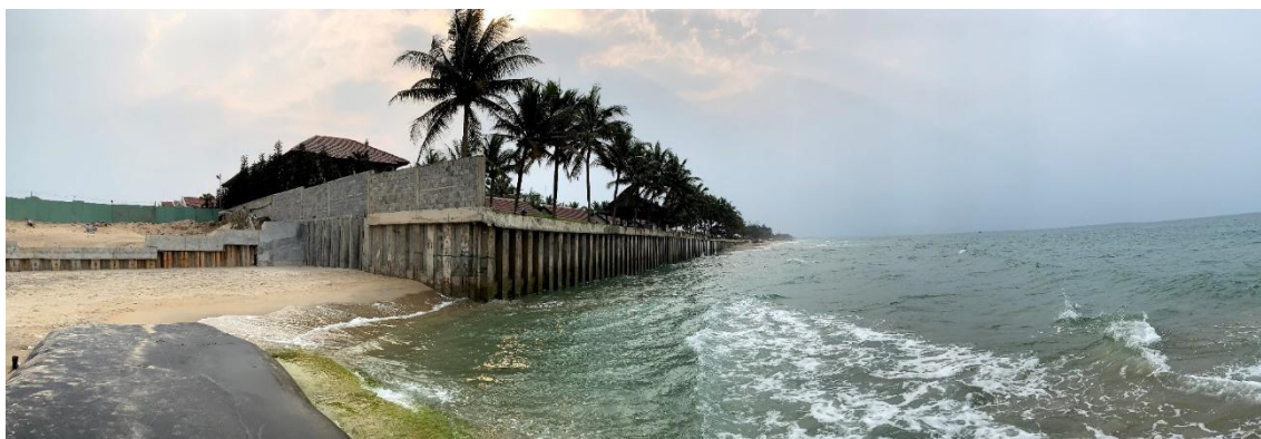
Hình 2.15. Tường/kè phía ngoài khu du lịch Palm Garden Resort Hoi An làm mất bãi biển, nguy cơ xói lở lan truyền khu vực kế cận (ảnh Đặng Văn Bào, 6/2023)
