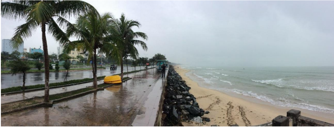
Hình 2.11. Xói lở bờ tây vịnh Đà Nẵng đang đe dọa tuyến đường ven biển Nguyễn Tất Thành (Nguồn: Đặng Văn Bào)
