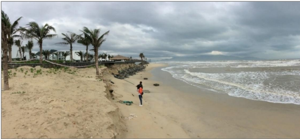
Hình 2.5. Xói lở bờ biển khu du lịch Melia Đà Nẵng do bão tháng 12.2017
