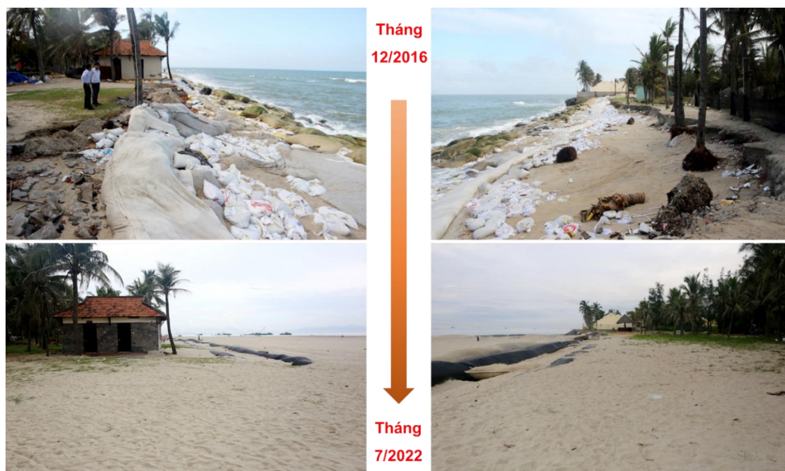
Hình 4.25. Bờ biển trước đường Âu Cơ, phường Cửa Đại thay đổi từ 2016 đến 2022 sau khi được gia cố kè bằng các bao cát (Nguồn: Đặng Kinh Bắc)
